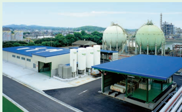
宇部ガスセンター
