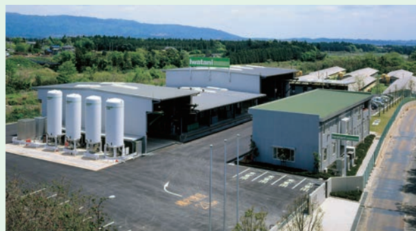
三重ガスセンター
