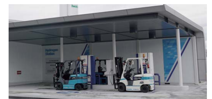
関西国際空港 産業車両用水素インフラ(フォークリフト用)
